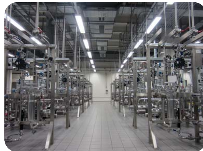
2009年 重庆力帆三溪口工厂 涂装车间油漆循环系统
