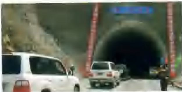
北京中隧隧道工程有限公司承建项目
